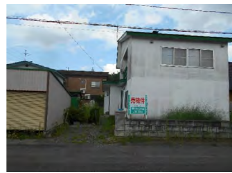
南東側より撮影
